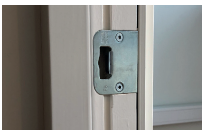
Infällda slutbleck som standard
