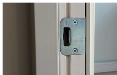
Infällda slutbleck som standard
