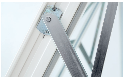
Dolda beslag och ej synliga från utsidan
